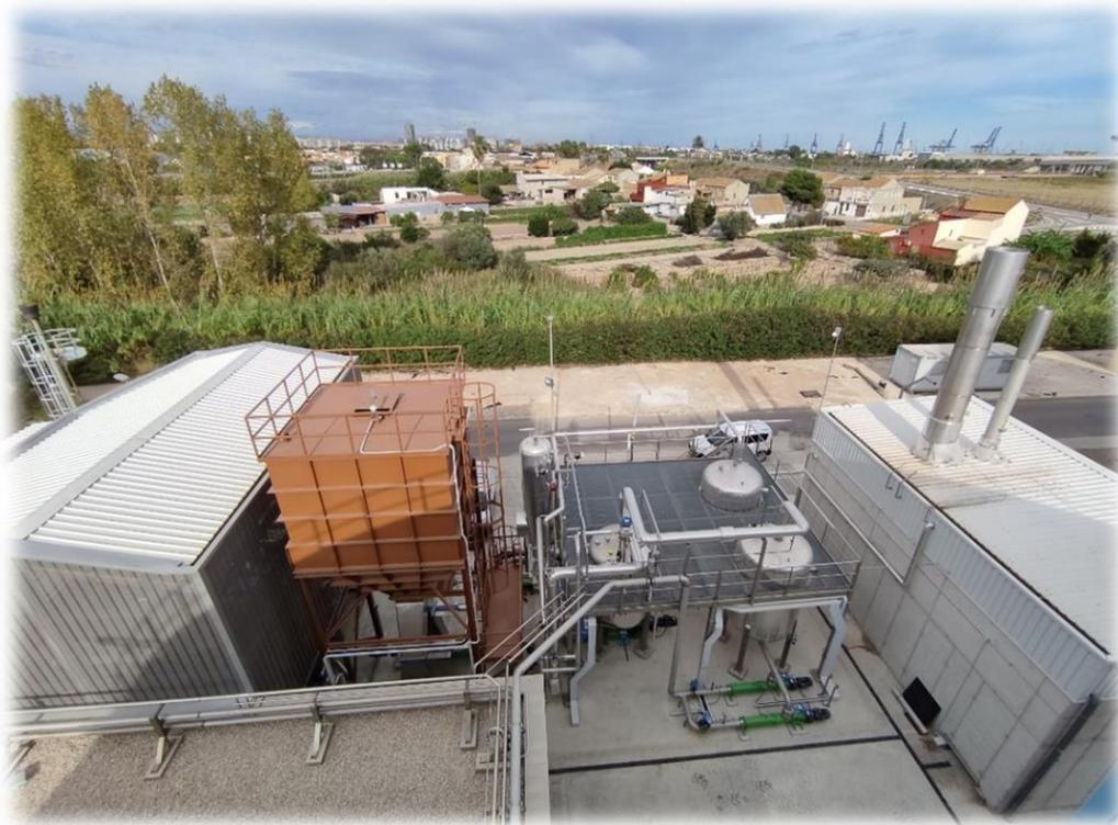
Figura 15. Integración de la HT en la EDAR Pinedo (Valencia). De izq. a dcha.: sala de centrífugas, silo intermedio (marrón), planta de HT y sala de caldera.
